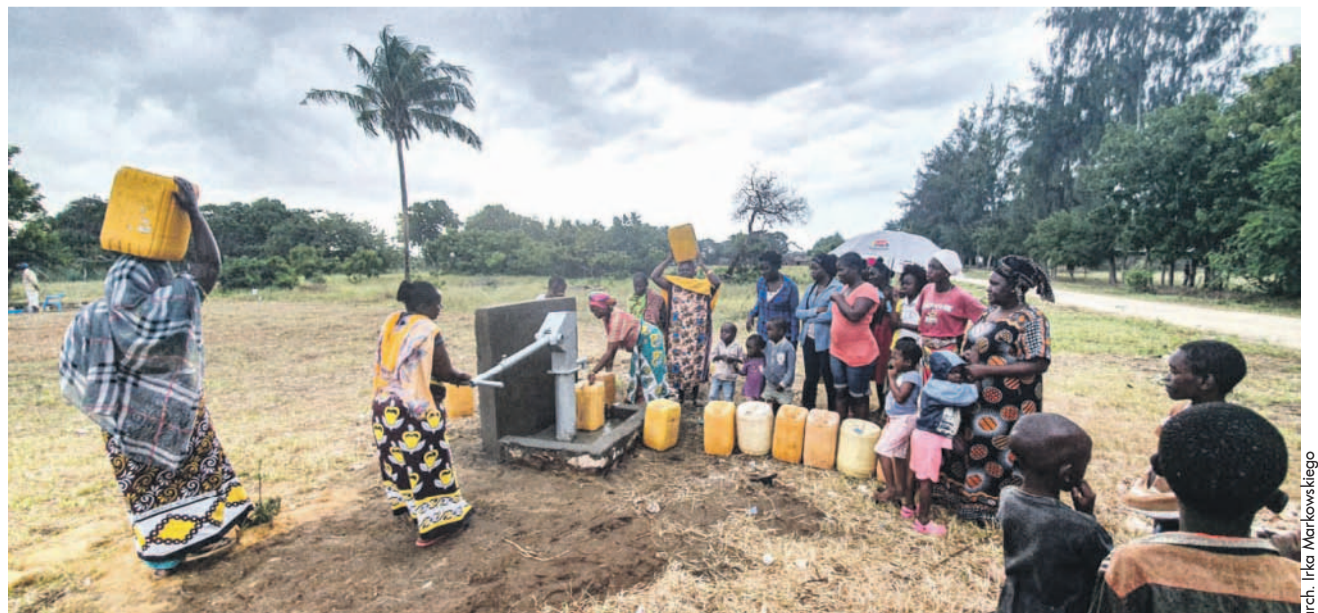
Druga studnia jest 100 km na północ od Mombasy. - W tym przypadku zamontowaliśmy pompę ręczną - mówi Irek. - Ze studni korzysta około 400 dorosłych osób oraz 300 uczniów z pobliskiej szkoły
